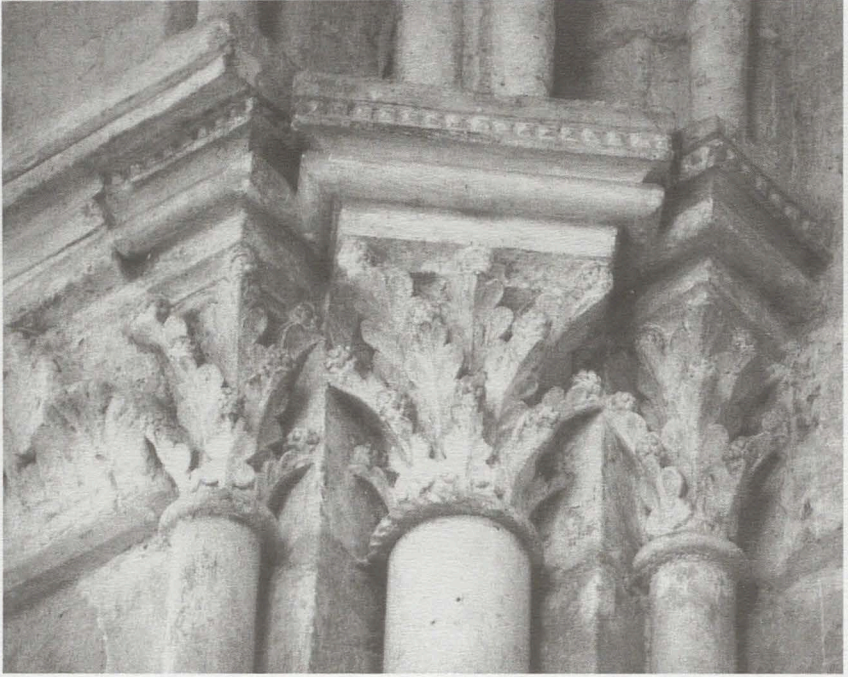
Saint-Jean-en-l'Isle. Extrémité sud-est de la nef. Détail de la rupture (cl. M. Boccard-Billon).
